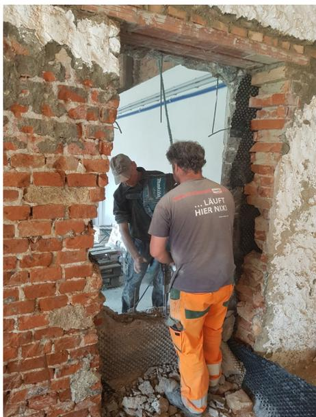
brochen (Türen und Theke) sowie der „Tiroler Putz“ von der Außenwand abgeschlagen. Bei einer Mauerstärke von 60 cm (30 cm Beton + 30 cm Ziegelmauer) kein leichtes Unterfangen, aber am darauffolgenden Tag war die Arbeit erledigt und der anfallende Bau-
